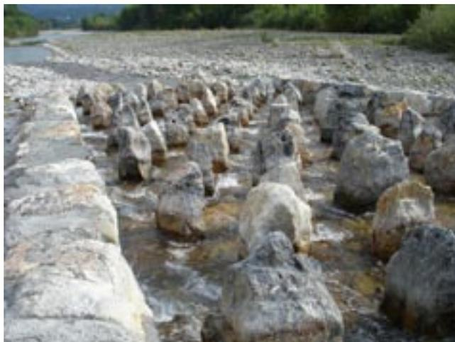
Fig. 5.6 – Scala di risalita per pesci del tipo “Single boulders” sul Fiume Vara in Comune di Follo.
