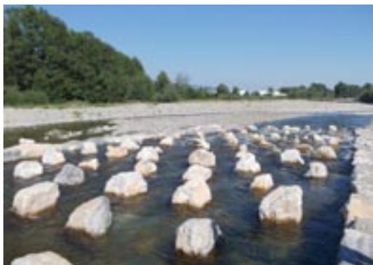
Fig. 8.1 - Passaggio per pesci VR02 realizzato con massi ciclopici.
